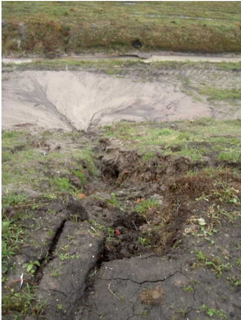
Foto: Erosie van afdeklaag.
